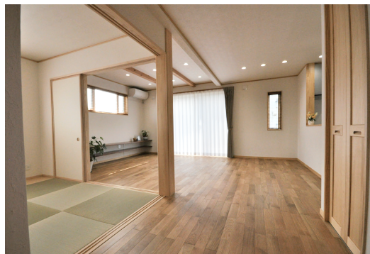
正面にある大黒柱は、桧6寸を使用しました
