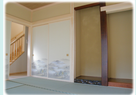
床框 / 思い出のえんじゅの床柱を再生しました
