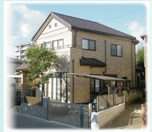
重厚感のある落ち着いた外観はタイルを使用しています
