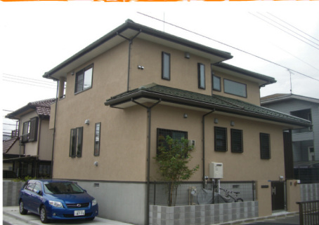
外観はすっきりと飽きのこない趣きに仕上げました。
